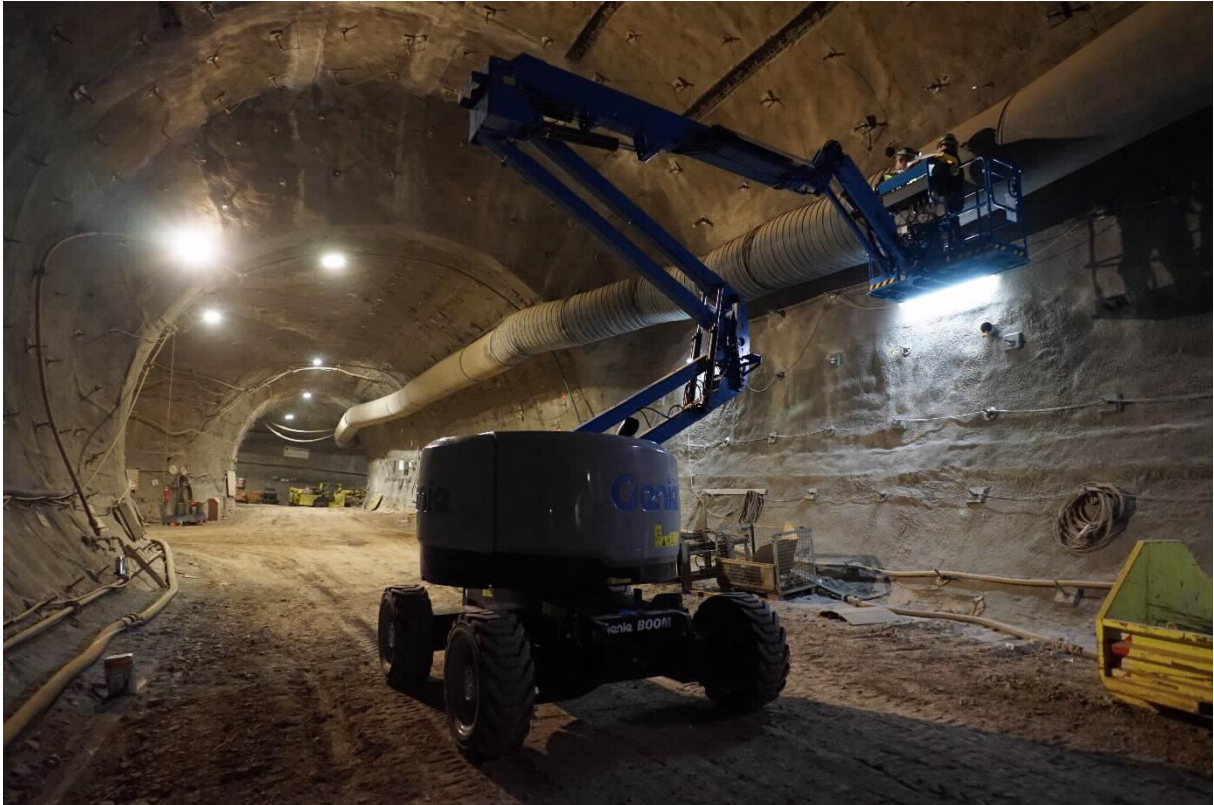
Genie Z-45 XC / Nach vorheriger Demontage unter Tage im Schacht Konrad komplett wieder montiert
