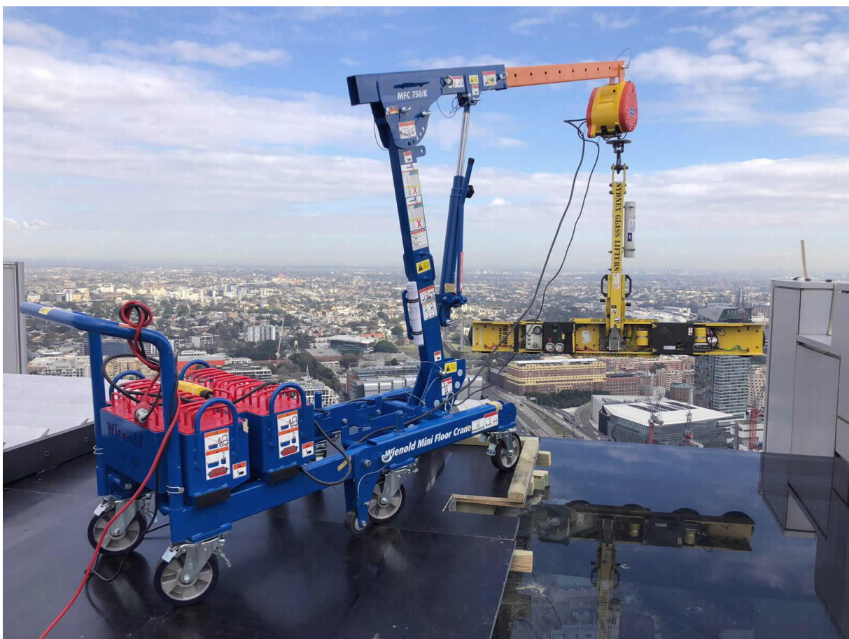
Wienold MFC 750/K Einsatz für die Glasmontage in Sydney, Australien
